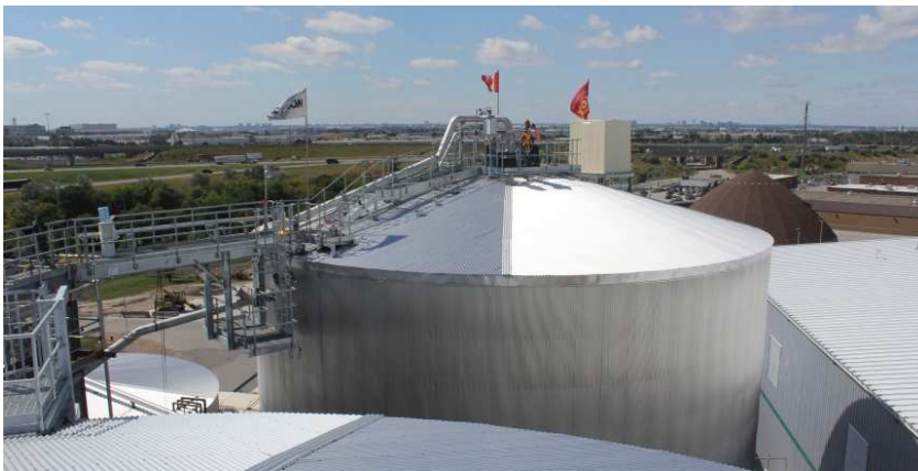
Abb. 5: Bioabfallvergärungsanlage Toronto Disco Road, 75.000 Mg/a
