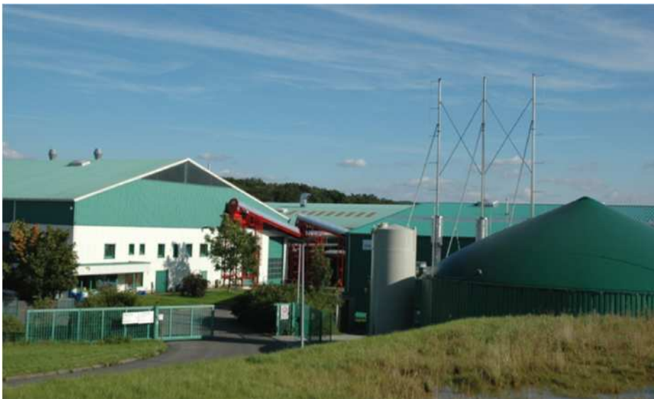
Abb. 1: KOMPOFERM ® -Verfahren Kompostwerk Nieheim-Oeynhausen
